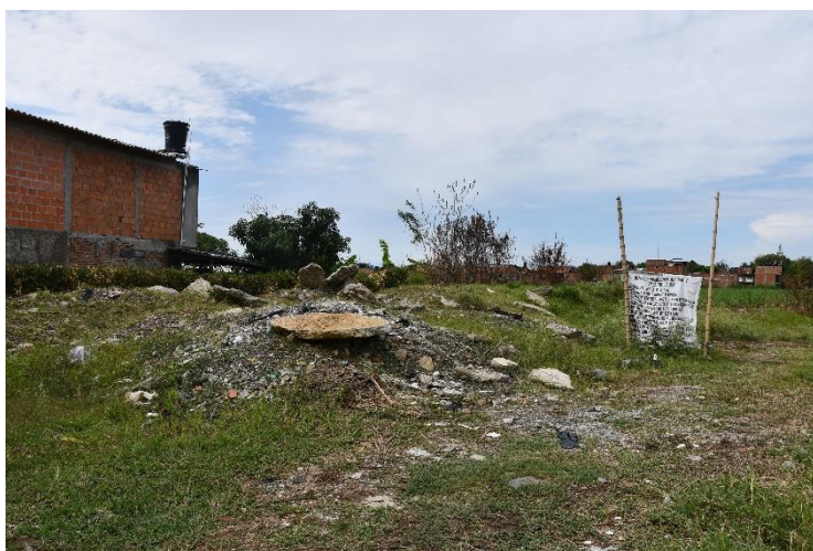
Foto 3. Sector Primavera – entrada Cabito, depósito de escombros
